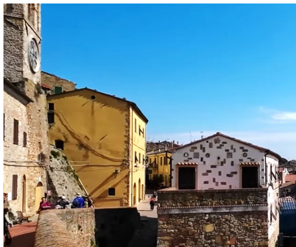
Figure 17 Facciata di fronte alla Torre Civica con inserti decorativi in pietra e laterizio a vista.
